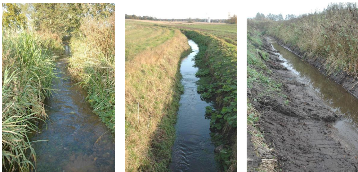
Foto 1. Grader af vandløbsvedligeholdelse (fra venstre): Nænsom skæring i strømrønde med bevareret udhæng. Omfattende skæring af udhæng i fuld bredde og til højre oprenset vandløb, hvor grundlaget for fisk og smådyr er væk.
